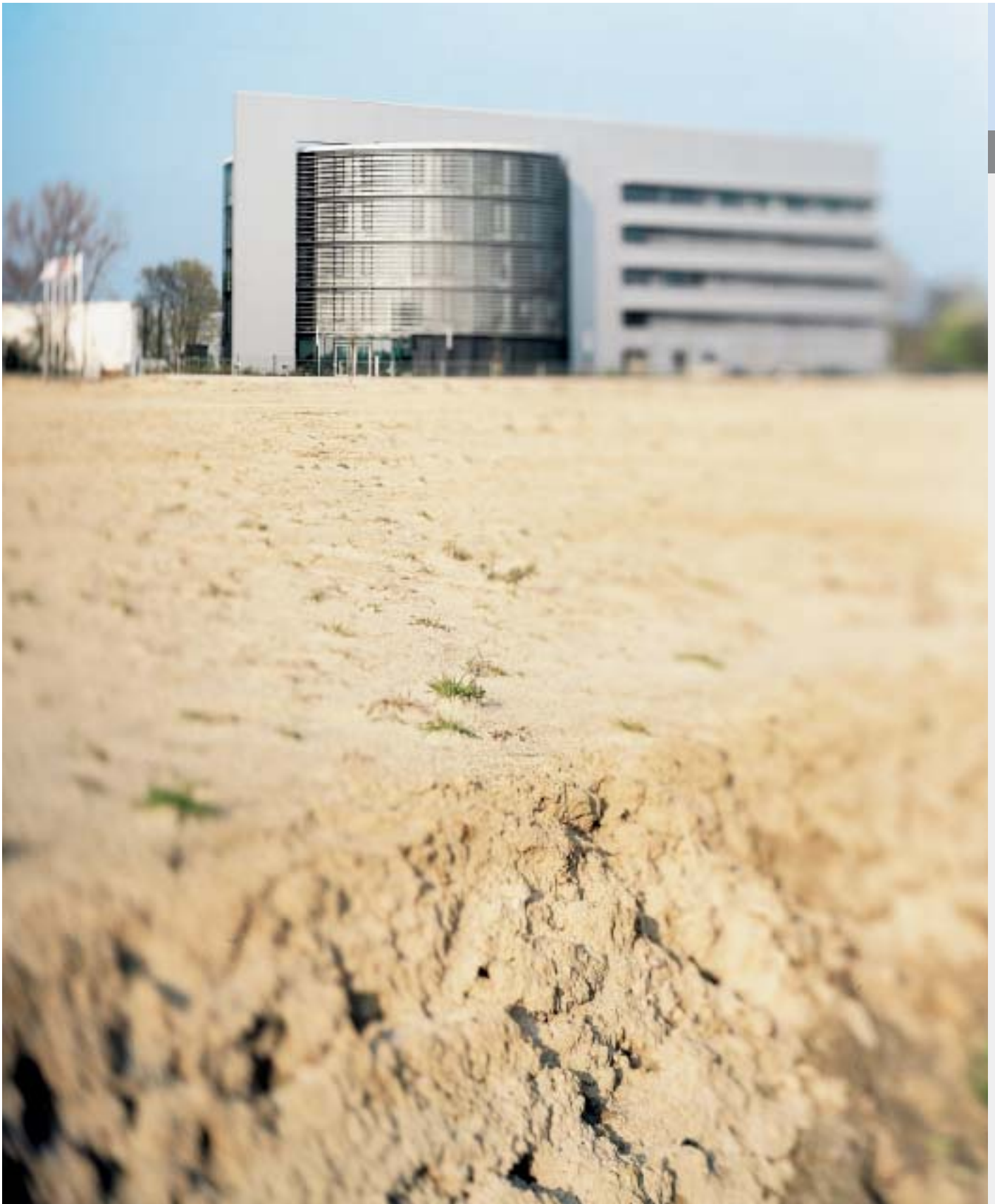
Technologiepark Universität, Süderweiterung, Neubau für die Unternehmen der Fuchs-Gruppe.
