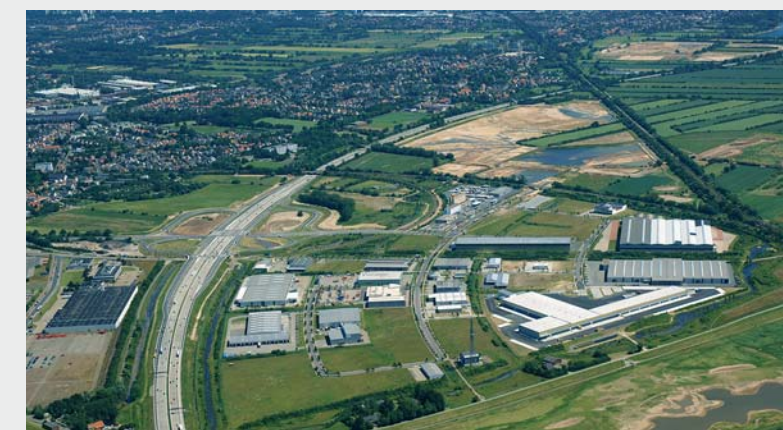
GVZ (oben): Ab 2007 mit eigenem Autobahnanschluss (A281) Hansalinie: 130 ha Logenplatz an der A1
