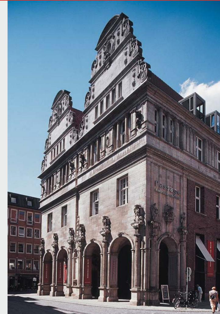
Kontorhaus am Markt mit neuer Passage
