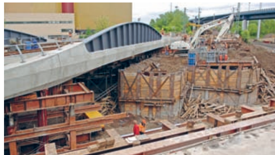
Ein vielschichtiges Brückenbauprojekt, realisiert unter schwierigen Bedingungen.
