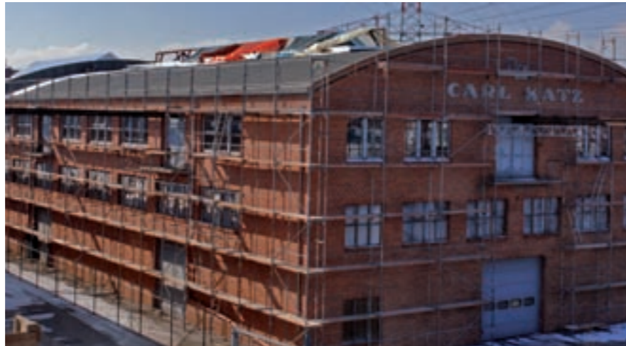
Die historische Tonnendachhalle wird zum modernen Dienstleistungszentrum.
