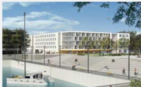
Bremium Investor: HOCHTIEF Projektentwicklung GmbH Fertigstellung im Frühjahr 2010
