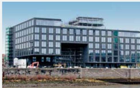
Beluga-Unternehmenszentrale Investor: Beluga Shipping GmbH Fertigstellung Ende Mai 2009
